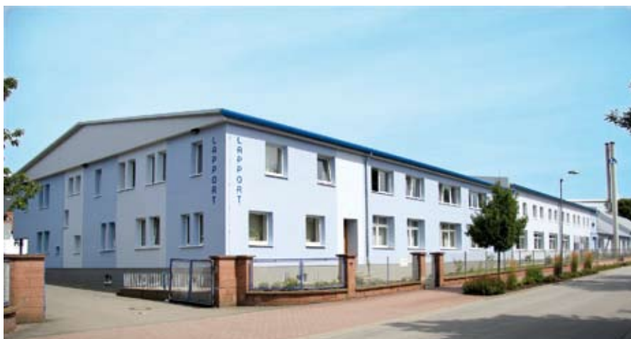
Lapport Schleiftechnik, Werk in Enkenbach-Alsenborn
